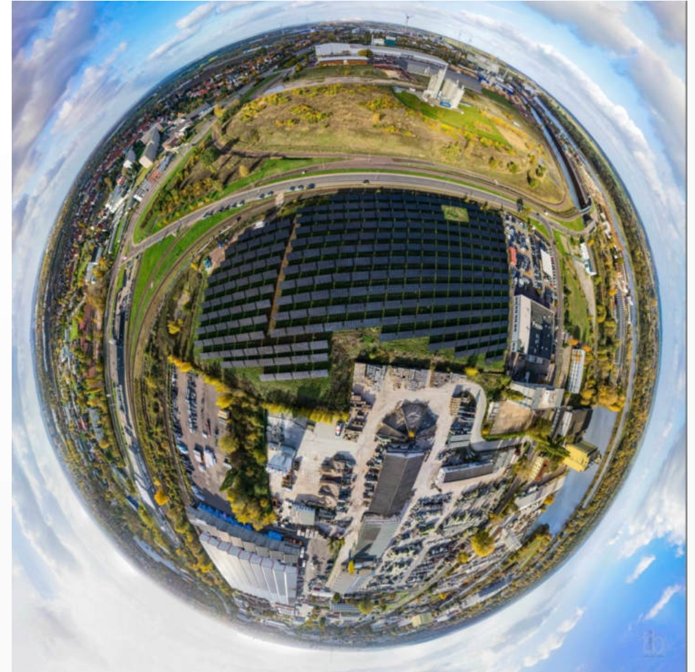
991,92 kWp Freiflächenanlage Magdeburg-Rothensee („BEMA Halde“)
